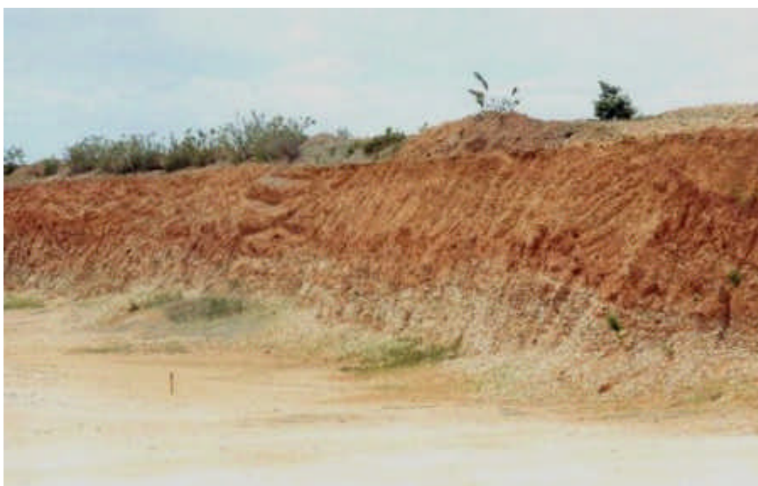
Foto 4.6 – Corte do terreno sedimentar da Formação Faceira, à jusante do dique fusível do Açude Castanhão.
