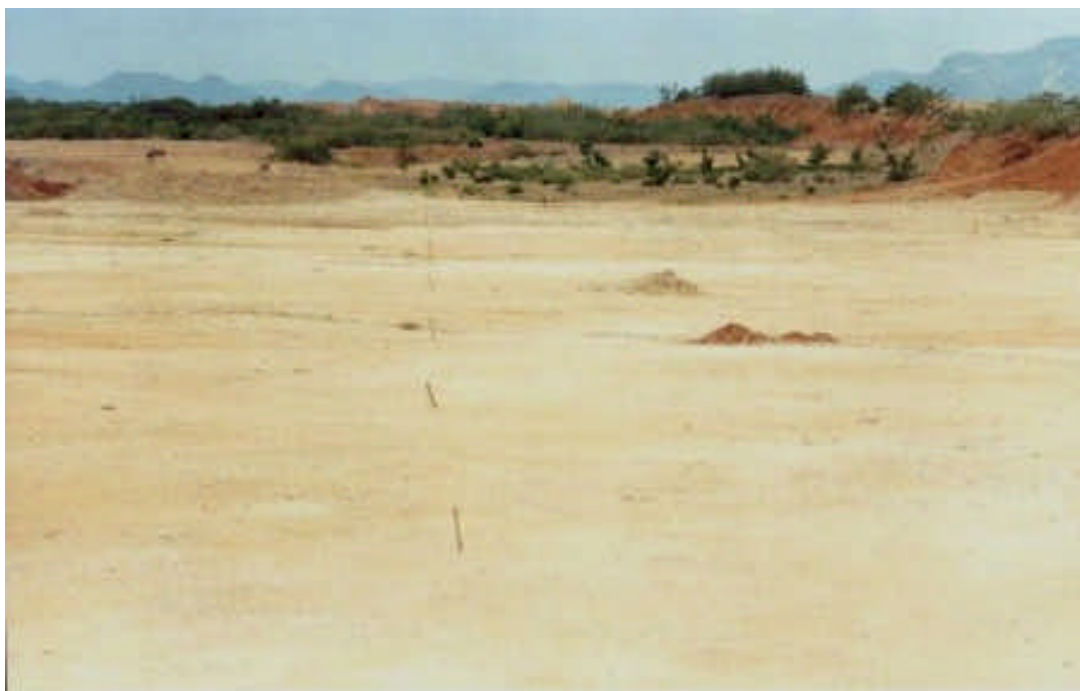
Foto 4.5 – Eixo da adutora no terreno plano escavado, formado por sedimentos da Formação Faceira, à jusante do dique fusível do Açude Castanhão.
